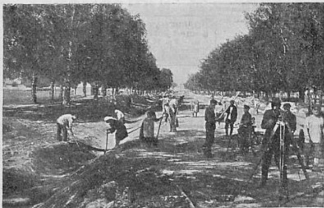
„Прокладка нового шоссе“. Фото А. Шишкина (г. Советск) Премиров. на автодорожном фотоконкурсе по 1 категории
